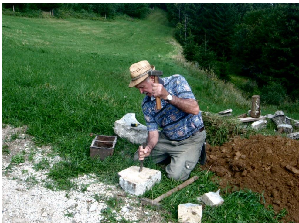
Slika 2: Franc Švajger cepi kamen za obnovo kapelice v Hudem Kotu (Ribniški Kopnik, 2010)
